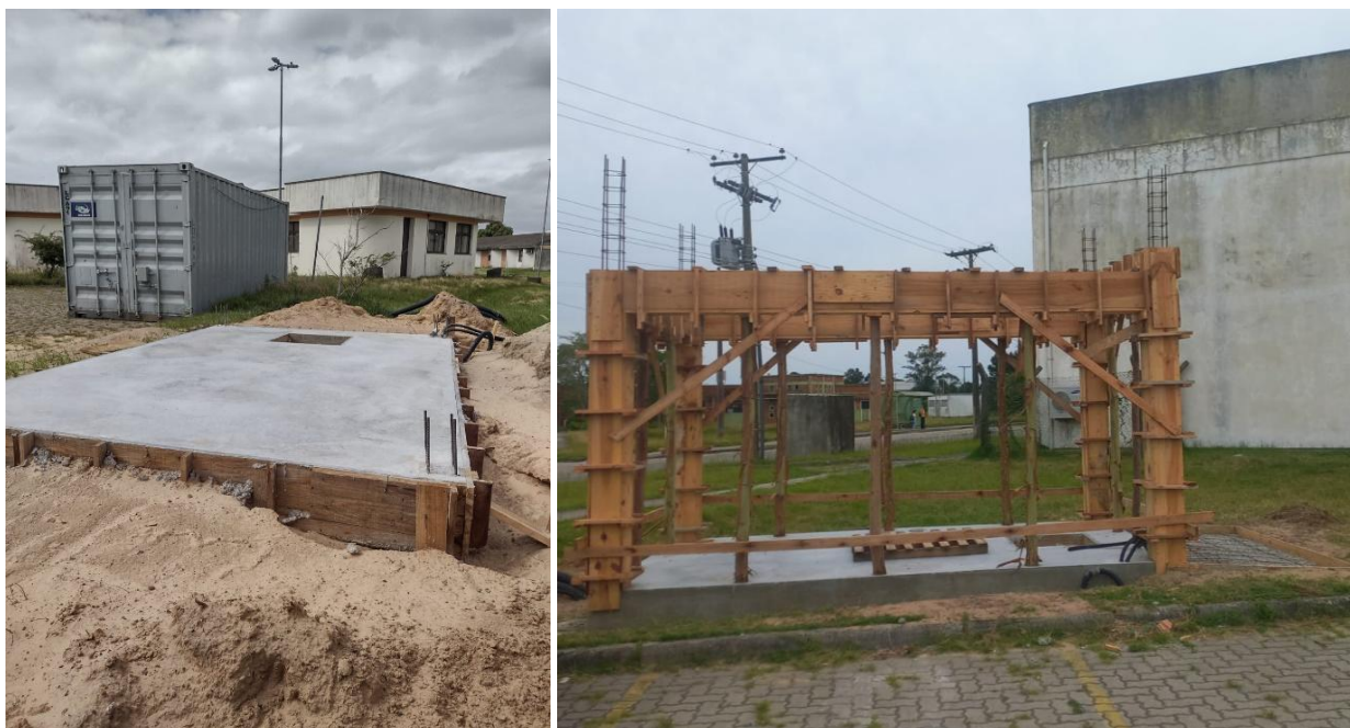
Figura 16. Obras de instalação de gerador no centro de Microscopia Eletrônica do Sul - CEME-Sul (à esquerda) e Centro Integrado de Análises – CIA-FURG (à direita), em novembro de 2024.
