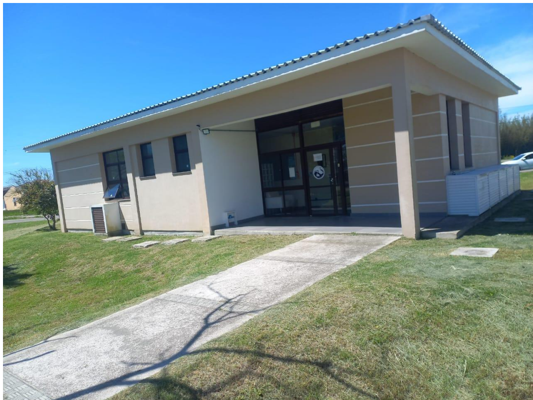
Figura 18. Laboratório de Aves Aquáticas e Tartarugas Marinhas do ICB, em construção em abril de 2021 (acima) e em uso em outubro de 2025.
